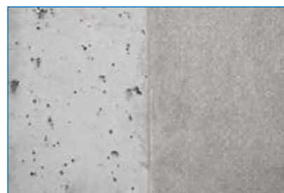
Links ohne Zemdrain®, rechts mit Zemdrain®.
